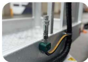
Linie de aer/apă sub presiune în coș
